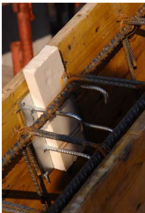
1.1 Posizionamento della piastra Coulisse prima del getto
