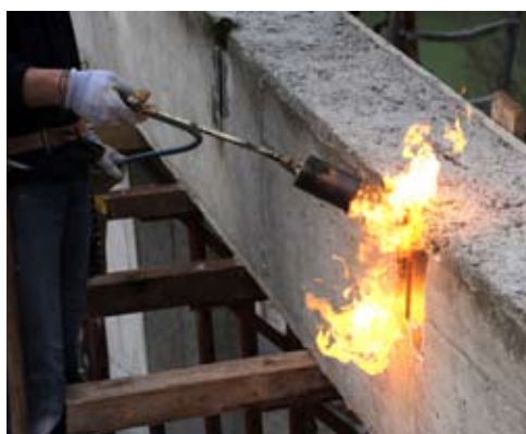
2.3 Rimozione del polistirolo o polistirene dalla piastra Coulisse
